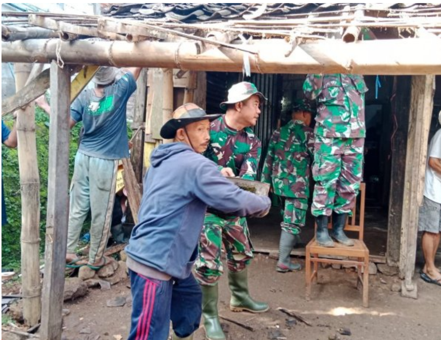
Pembongkar Rumah Sasaran RTLH
